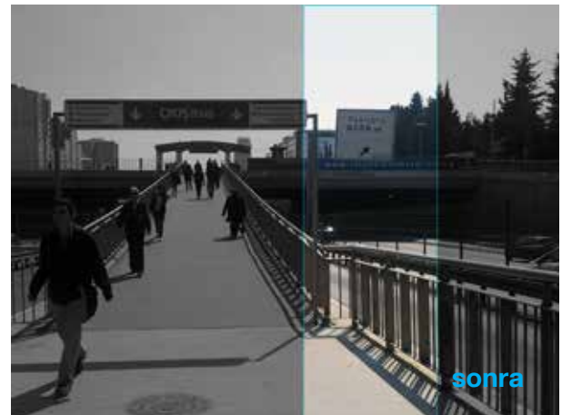
Şekil 27 Üst-alt geçitlerin platformla birleştiği alanlarda yolcuların metrobüs yoluna inmemesi için kapatılması
