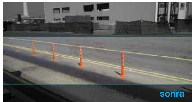
Şekil 13 Bazı istasyonlara otobüslerin platforma yakın yanaşmalarını sağlamak amacıyla dubalar yerleştirmiştir
