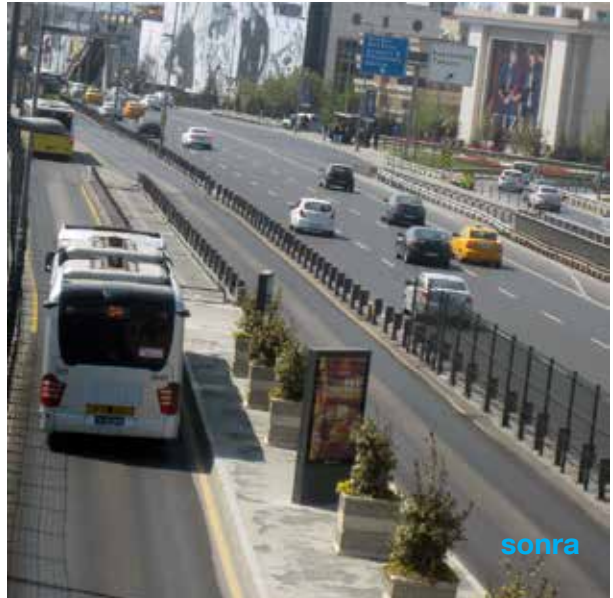
Şekil 21 Platformlarının sınır bölgelerinin kapatılmamış ve korkulukların hayalet adaların sonuna kadar uzatılmamış olması
