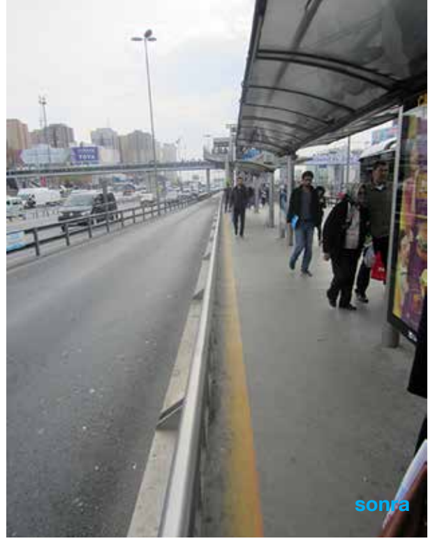
Şekil 20 Bekleme sınır alanının sarıya boyanması ve üzerindeki yol bozukluklarının giderilmesi
