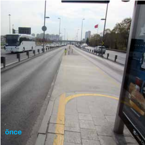
Şekil 21 Platformlarının sınır bölgelerinin kapatılmamış ve korkulukların hayalet adaların sonuna kadar uzatılmamış olması
