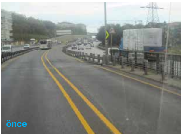
Şekil 17 Metrobüs yol kaplama bakım- onarım çalışmaları
