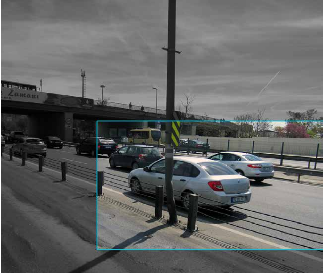
Şekil 24 Direklerin çarpmaya karşı korunmamış olması
