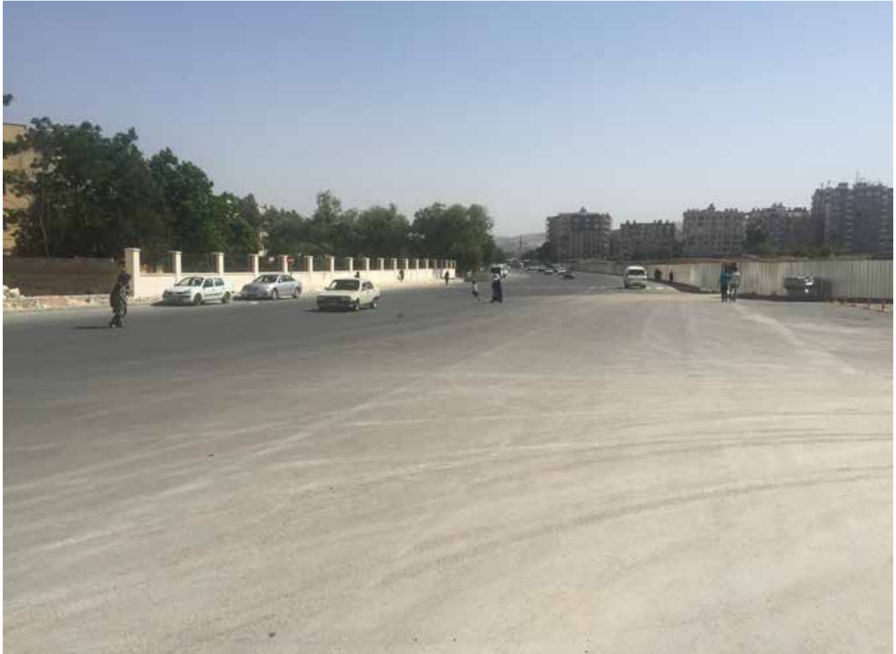
Şekil 88 Yol Platformu Üzerinde Yatay Yol İşaretlemelerinin Eksikliği (EMBARQ Türkiye, 2015)
