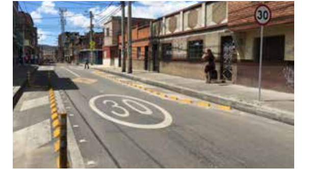
Şekil 10.12 | Tunjuelito'da Geçici Pilot Projenin Başarısı Üzerine Orta Vadeli Malzemeler Kullanılarak Oluşturulan Şişe Boğazları
