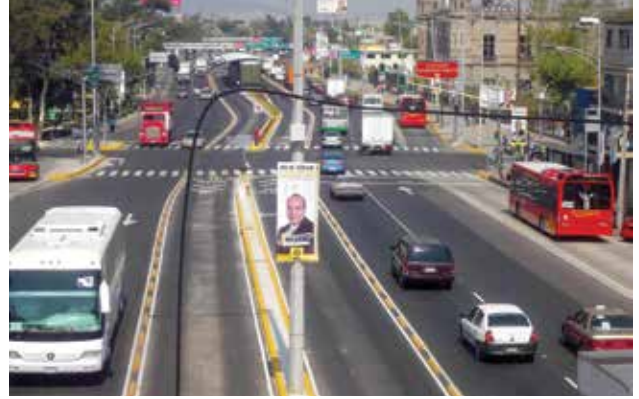
Şekil 86 Müdahaleden sonra Eje 3 Oriente, Metrobüs hattı 5 ve iyileşmiş yaya altyapısı için Metrobüs (BRT) hatlarını göstermektedir.
