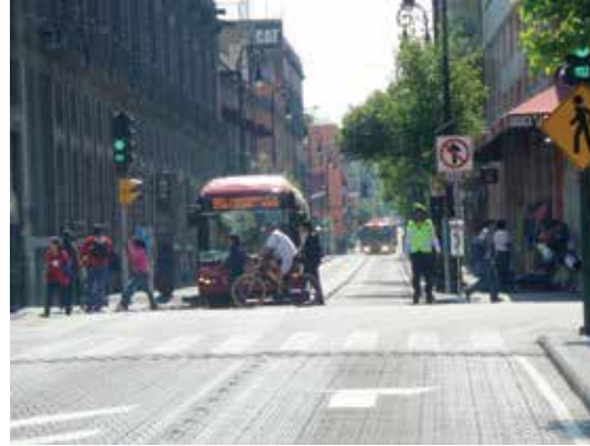
Şekil 46 Karma trafikteki sağa dönüşlerde, paylaşımlı şeridin bitişi ve ayrılmış otobüs hattının başlangıcını belirten trafik ve kaldırım işaretleri.
