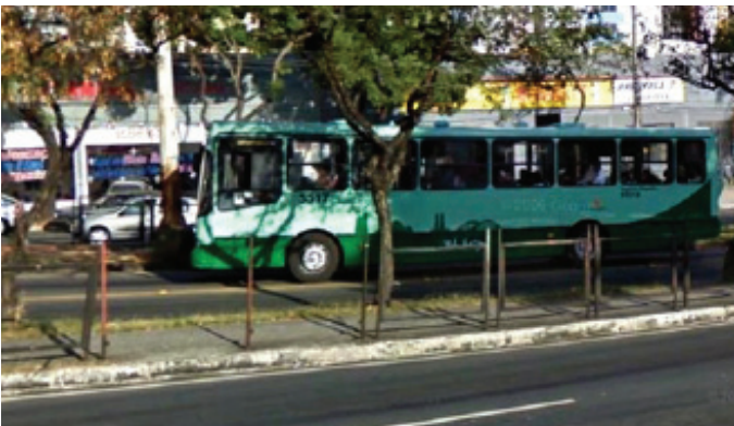
Belo Horizonte, Brezilya'da bir otobüs yolu boyunca hasar gördüğü için orta blokta geçişe olanak sağlayan bir korkuluk. Fotoğraf Carsten Wass.
