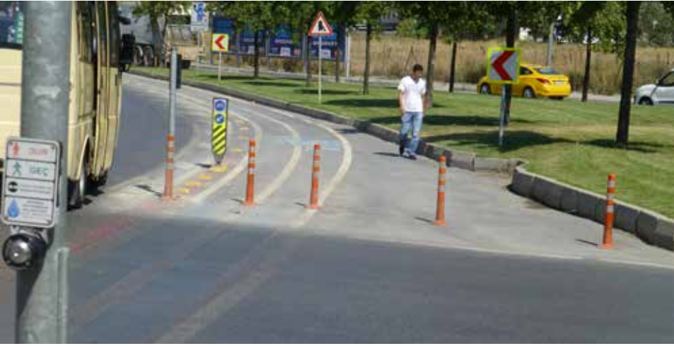
Devam etmeyen kaldırım
